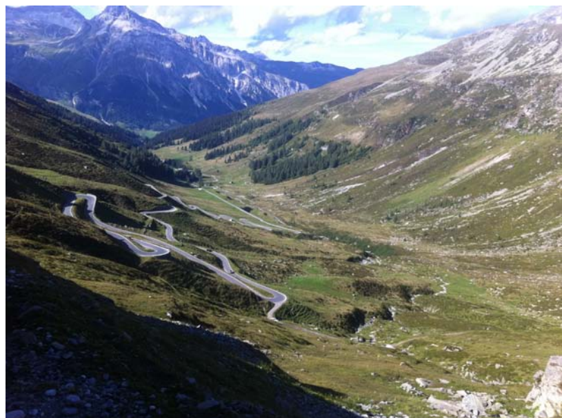
Abbildung 3: Splügenpass: Abfahrt nach Splügen
